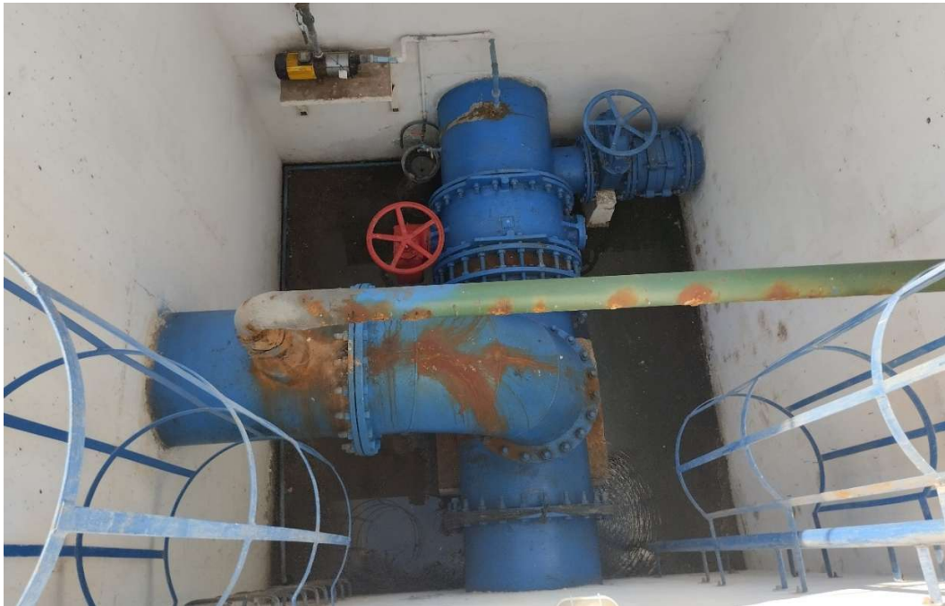
Imagen, condición de brida previa a encapsulado.
